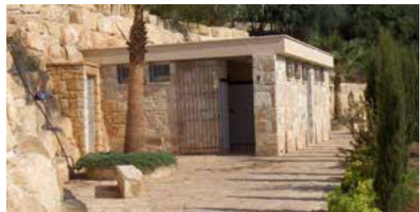
Κατασκευή δημόσιων αποδυτηρίων στην κοίτη του ποταμού.
