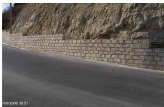
Κατασκευή καλλωπιστικού τοίχου, στην οδό Μακεδονίας.
